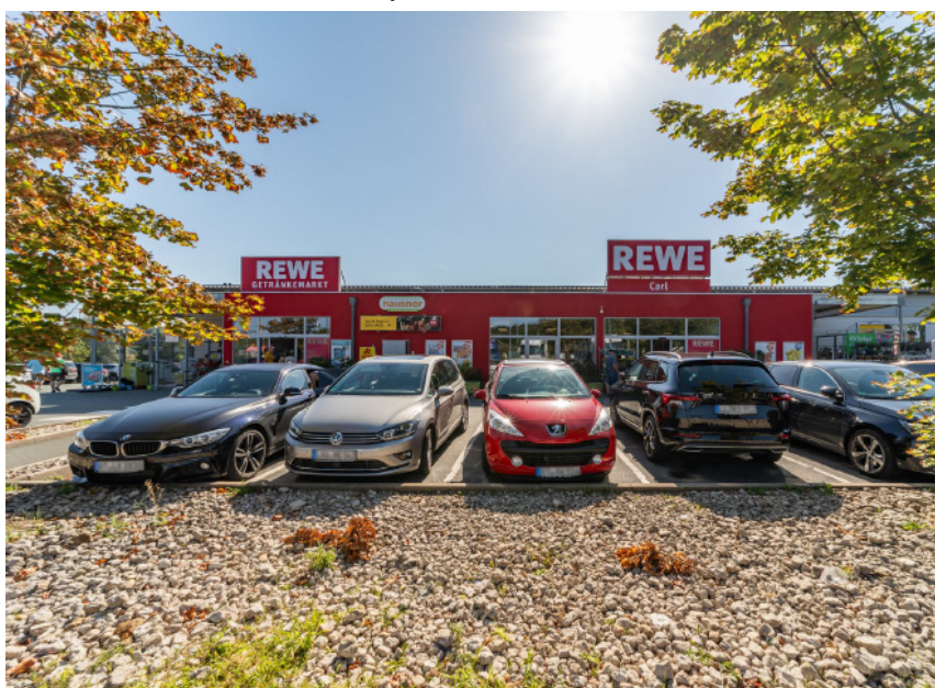
FIM Lebensmittelvollsortimenter in Plech mit Fachmarkt und Solardach. Mit 8.100 qm Mietfläche und einer Grundfläche von 24.650 qm das größte Objekt eines Paketkaufs 2019 mit vier Einzelhandelsimmobilien.
